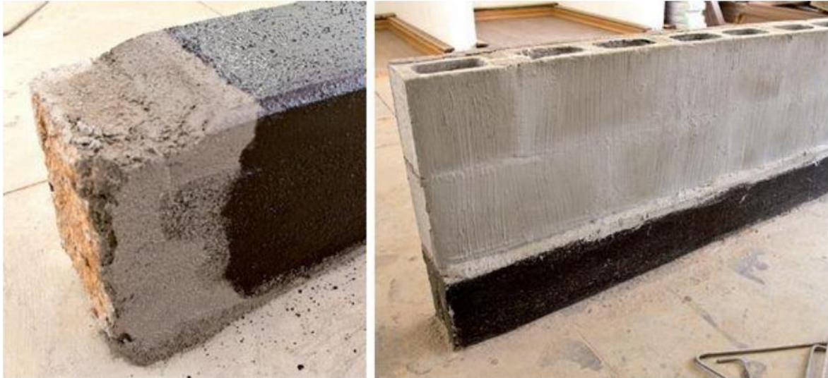
Figura 2: Impermeabilização de superfície de concreto.
